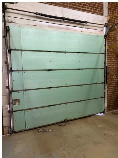
Garage Door Inside
